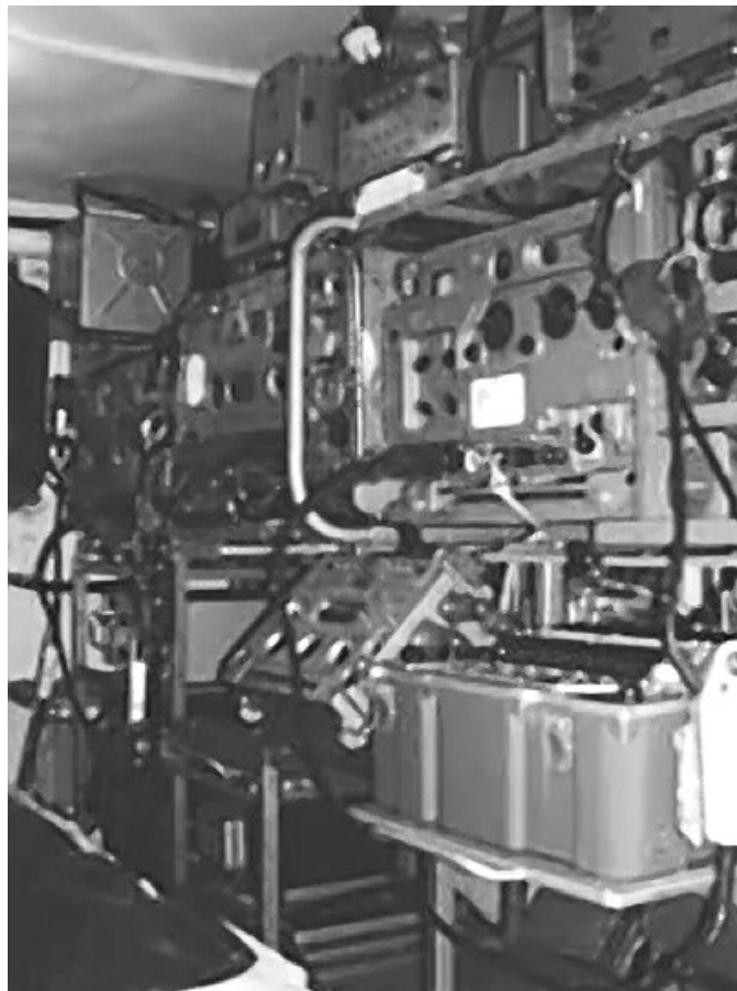
Im Kabinett, die Geräte in der Gefechtskabine der SSR (PG)
