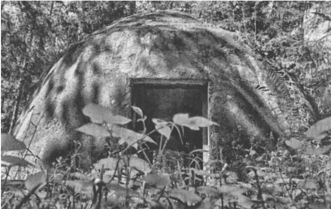
Der Notausstieg des Bunkers, in dem der HGS des STMCVM untergebracht war (HN)
